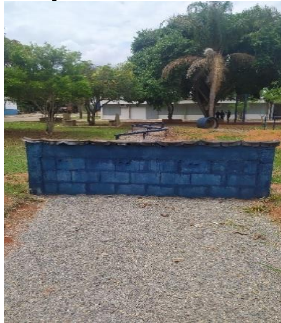
Figura 14: Muro de assalto baixo
